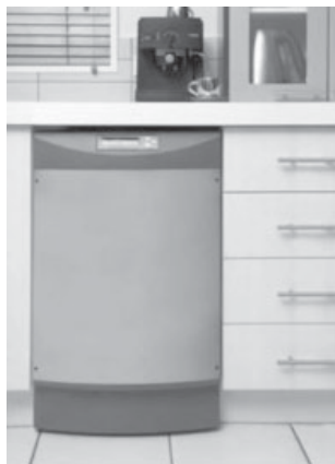
Рис. 2. На кухне генераторы типа MicroCHP можно спрятать со стиральной или посудомоечной машиной. Иногда генераторы ставят в подвале
