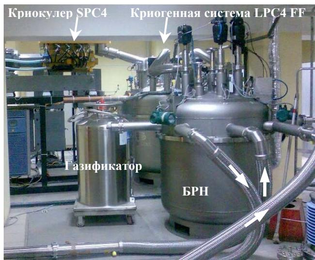
Рис. 3. Криогенная система и БРН. Показаны направления потоков жидкого азота.
