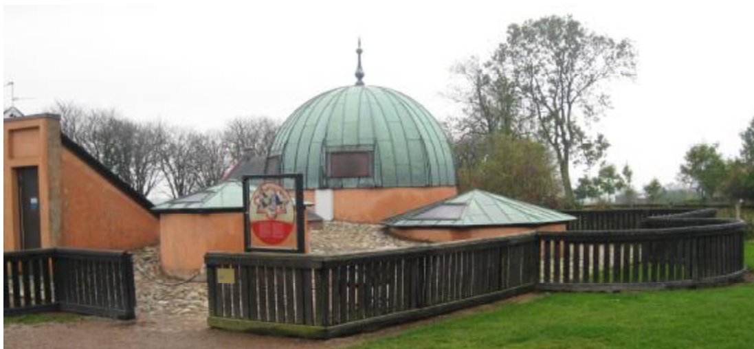
Реконструированное здание подземной обсерватории. Фото автора.
